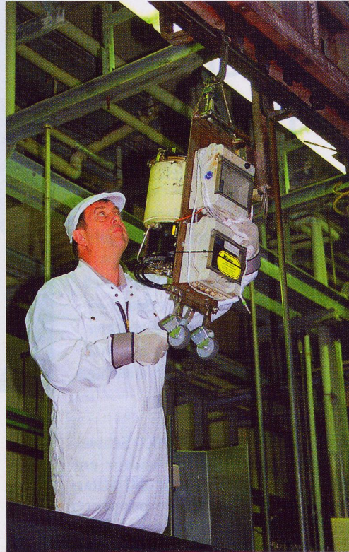
Von einem Podest aus wird die Schmiermittelpumpe an einer geeigneten Stelle in die Rohrbahn eingehängt.
