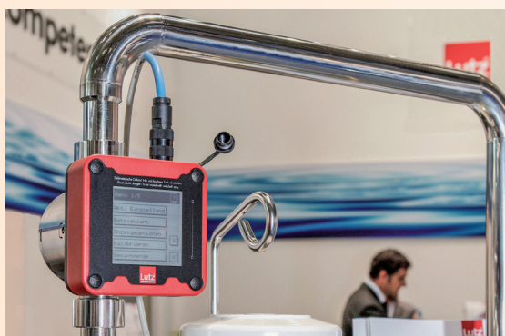
Mit Edelstahl-Hygienerahmen ausgerüstete Exzentrerschneckenpumpe MX20S-30/10 von Knoll
