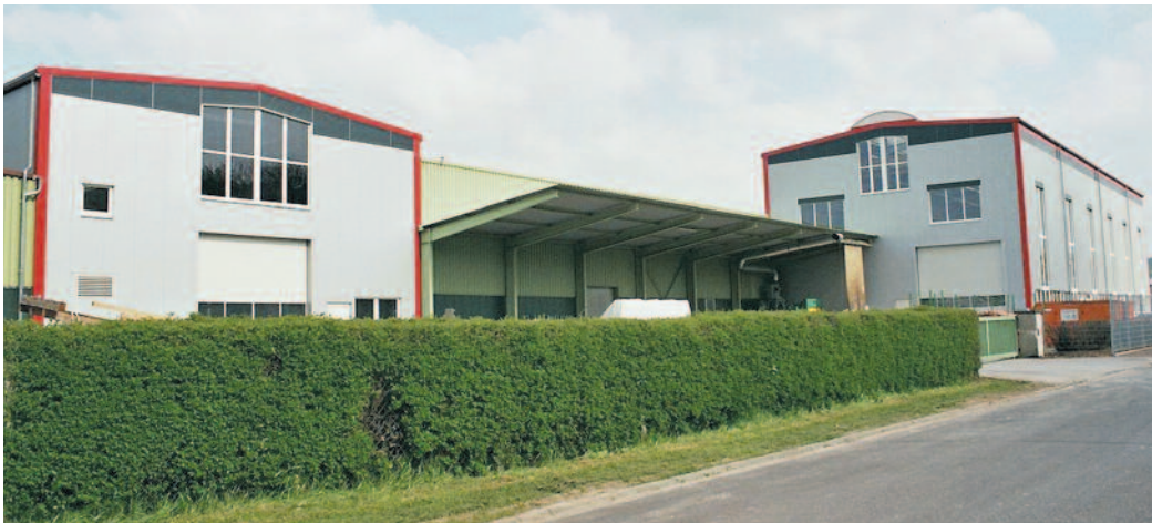
Links und rechts zu erkennen sind die beiden neuen KS-Produktionsgebäude in Creglingen
