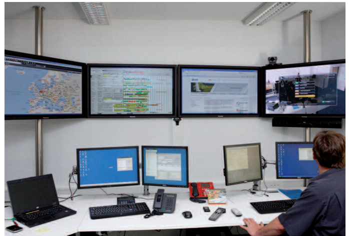
Der im Januar 2011 zur internationalen Baustellenkoordination installierte Leitstand in der KHS-Zentrale mutet durchaus futuristisch an
