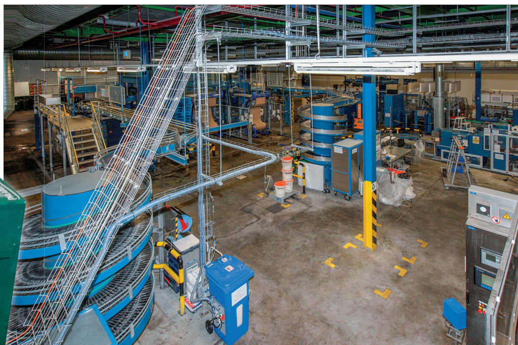
Eine besondere Lösung stellt die Verlegung der bis zu 30 m langen Förderschläuche auf max. 5 m hohen Metallgitter-Trassen dar.
