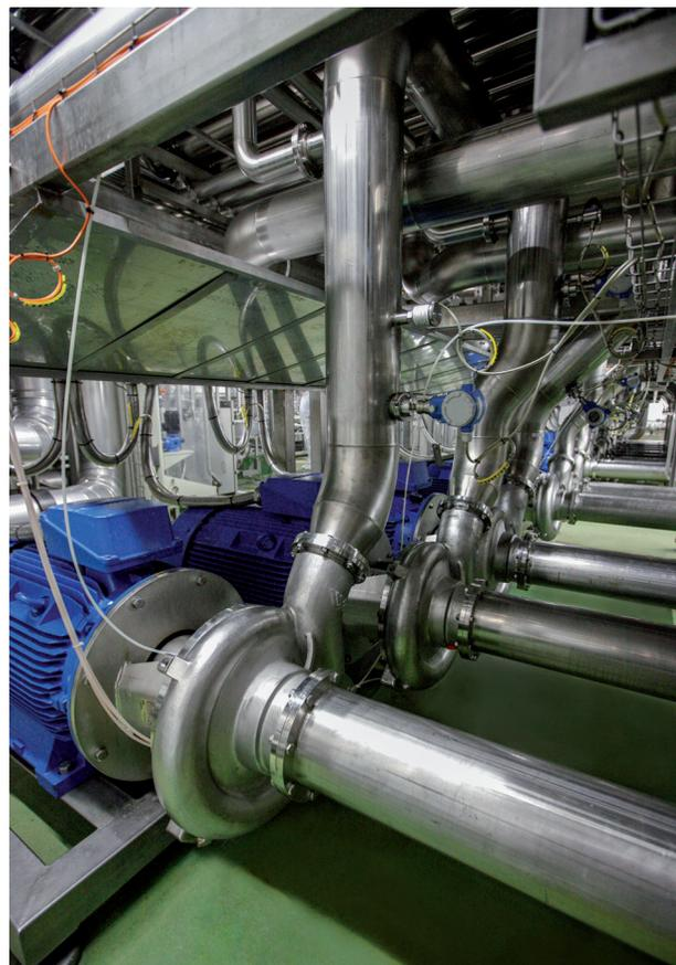
In der ersten Um-rüstungs-Phase wurden insgesamt 16 Packo-Kreiselpumpen des Typs MFP 3 mit einer Leistung von jeweils 90 kW verbaut.
