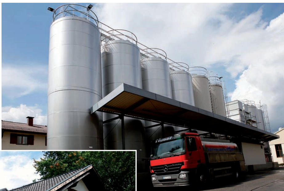
Zur Aufnahme der Milchanlieferungsmenge stehen sechs Tanks mit jeweils 120.000 Liter Fassungsvermögen zur Verfügung. In der Mitte sind zwei Heißwassertanks platziert (alle Fotos: Kimberly Wittlieb)
