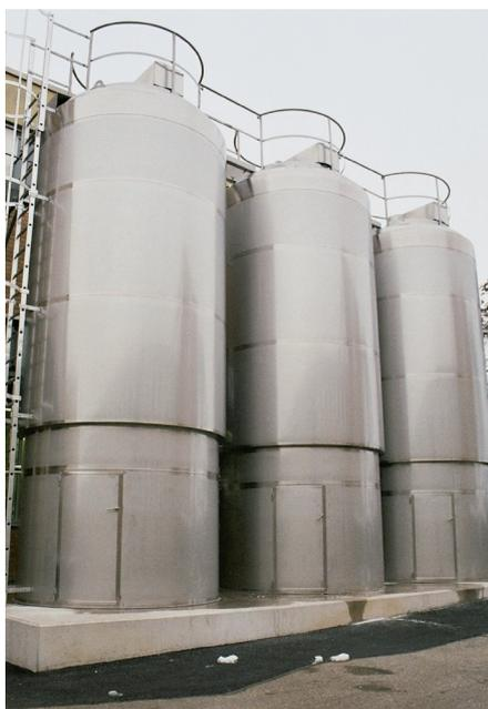
Die Butterei wird durch drei neu installierte Tanks mit insgesamt 60.000 l Fassungsvermögen gespeist
