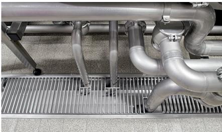
Schlammfang und Geruchsverschluss sind aus Edelstahl. Türen und Fenster entsprechen durch die komplette Fertigung aus Edelstahl den jeweiligen DIN- und EN-Vorgaben. Sie sind langlebig, korrosionsbeständig und nahezu wartungsfrei. Zum Schutz von Türen, Zargen und Ecken sowie insbesondere von Leichtbauwänden und Paneelwänden bietet der Hersteller individuell gefertigte Ramm- und Kantenschutz an.
