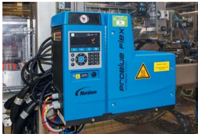
In Mechernich sind insgesamt 33 Schmelzklebstoff-Auftragsgeräte der Pro-Blue Flex-Baureihe von Nordson installiert.
