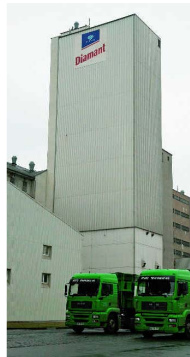
Bei einer Tagesleistung von rund 1 000 t schlägt sich der Inhalt des 4 800-t-Siloturms innerhalb kurzer Zeit um.
